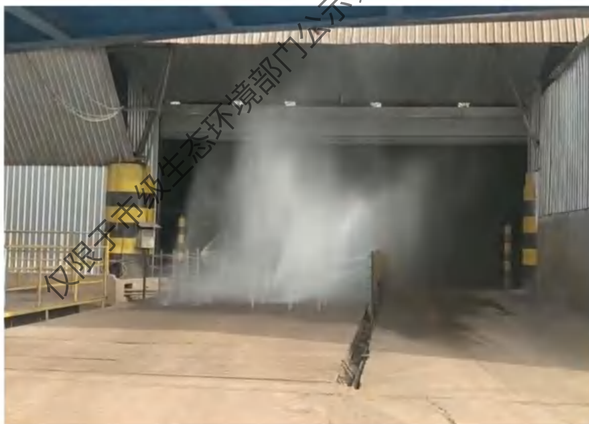
图5.1-12 烧结原料大棚洗车平台
