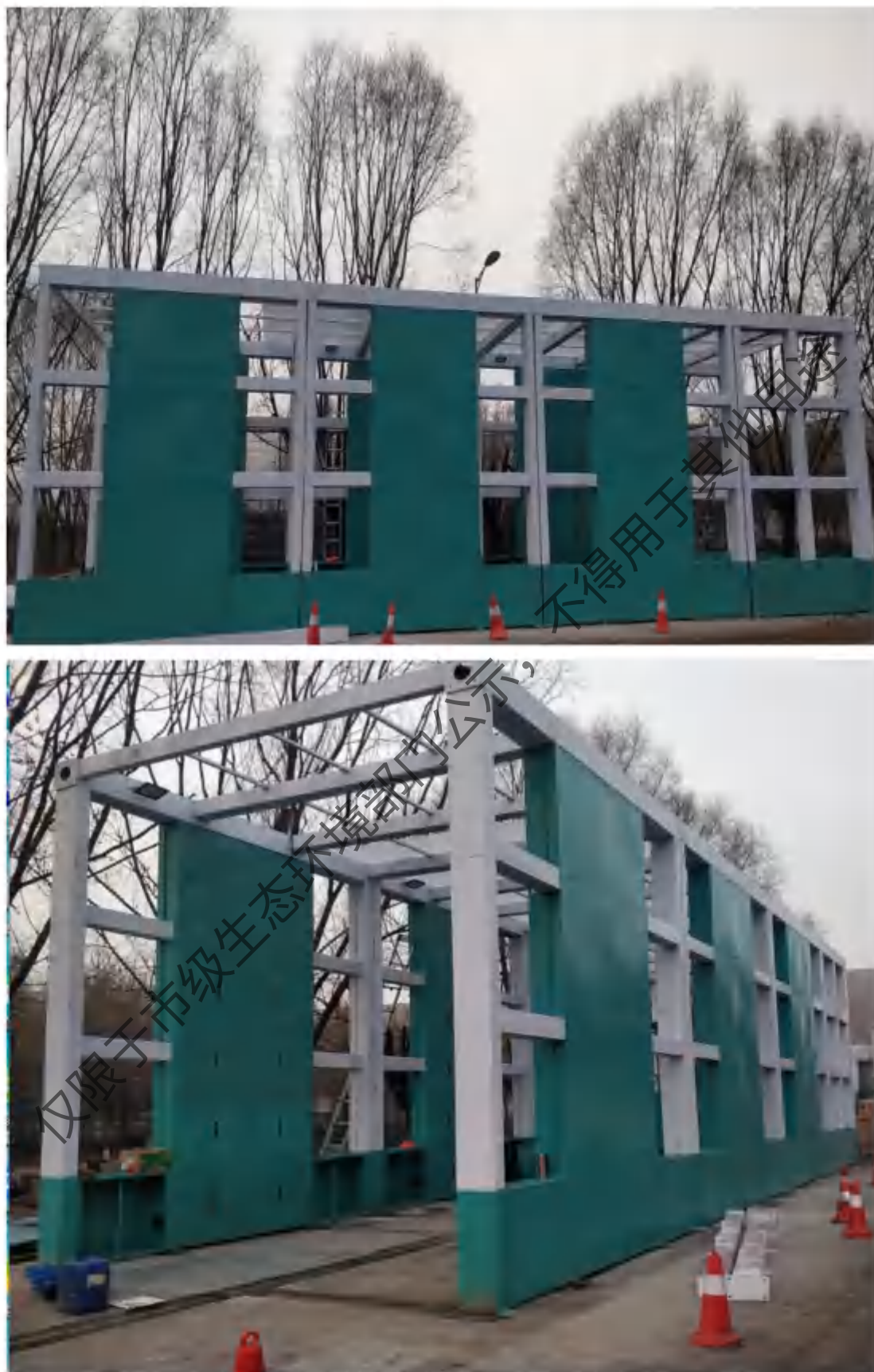
图5.1-13 建设完成的南门洗车平台
