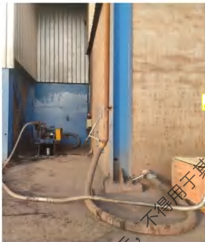
图 5.2-1 粉状物料运输过程控制措施
