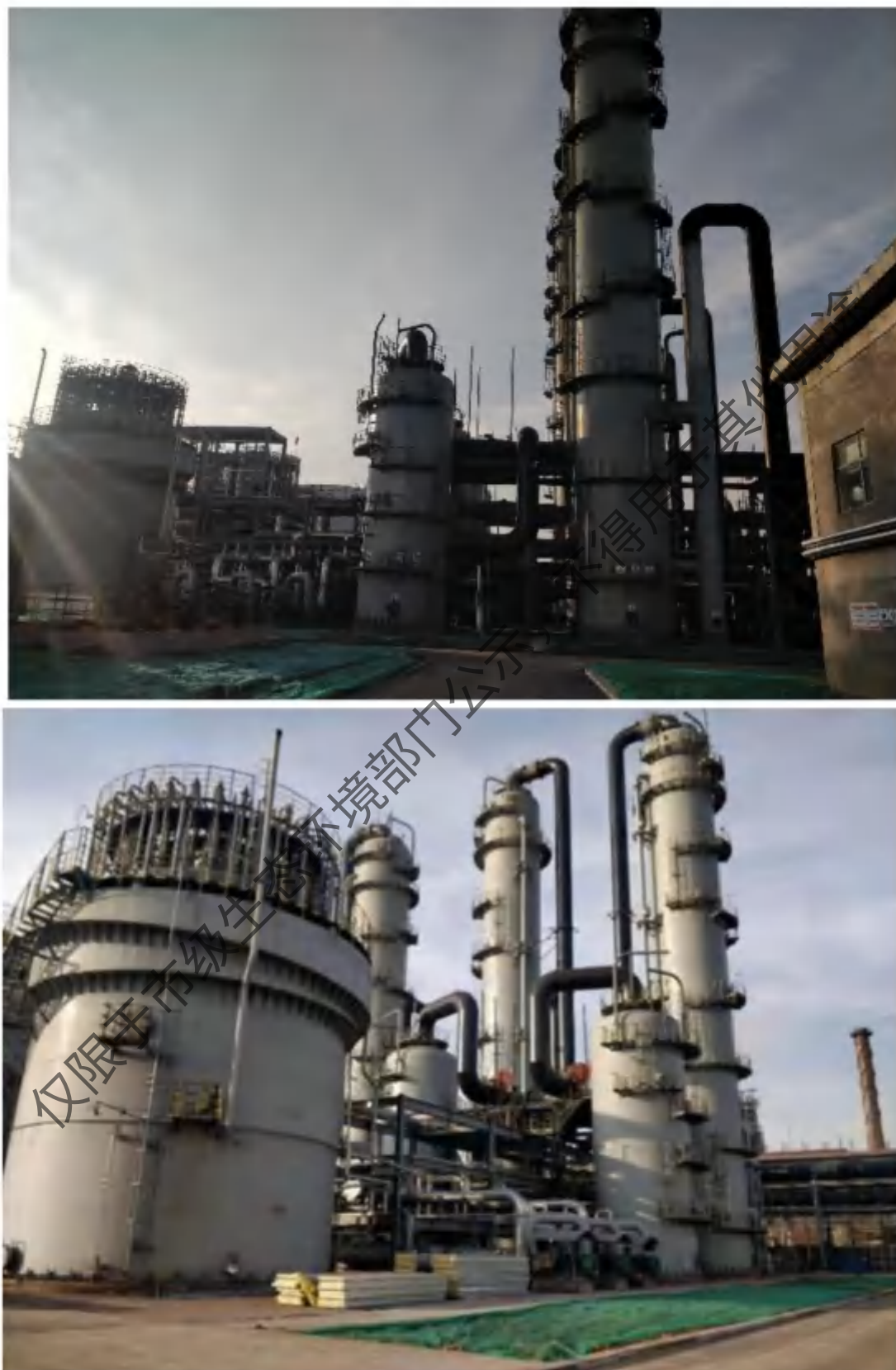
图2.6-4 高炉煤气精脱硫工段
