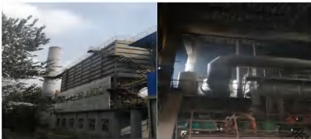
炼钢散装料除尘 炼钢高位料仓除尘
