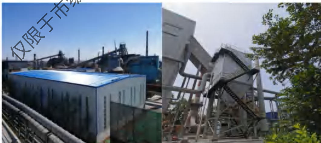
石灰石全封闭料棚
