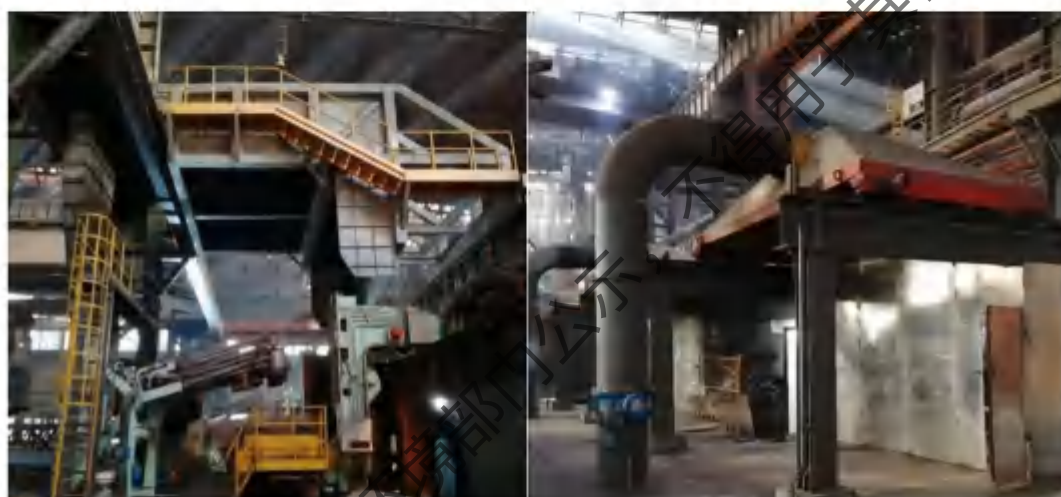
连铸机大包回转台除尘设施
