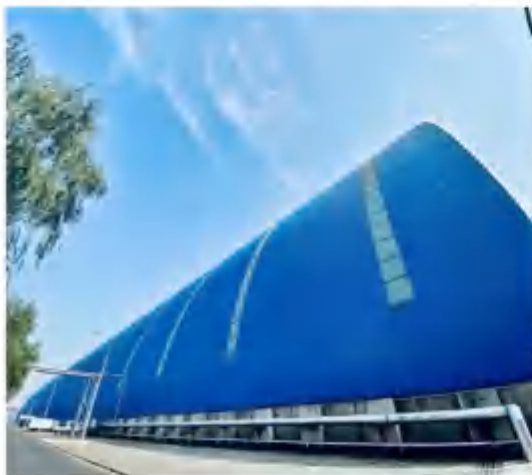
全封闭原煤大棚
