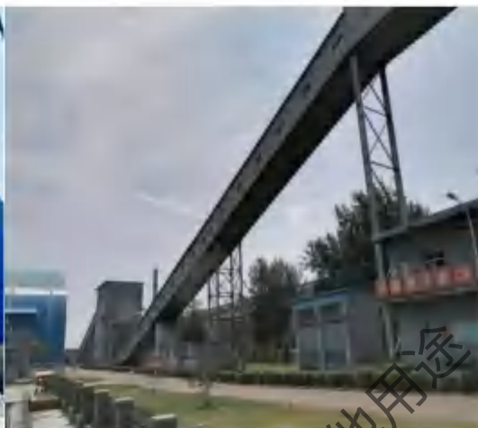
全封闭皮带通廊
