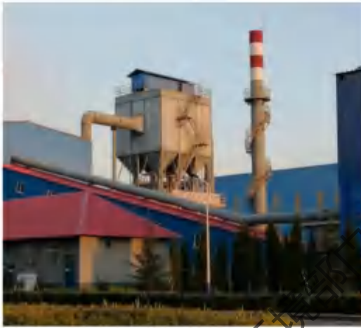
钢渣处理楼除尘
