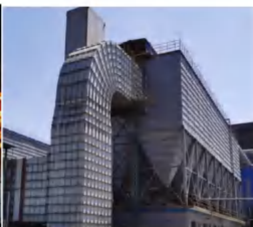
转炉转炉二次除尘
