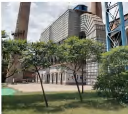
烧结机机尾除尘
