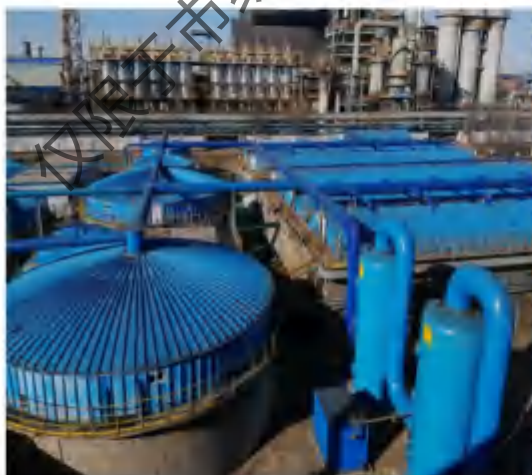
酚氰污水池封闭
