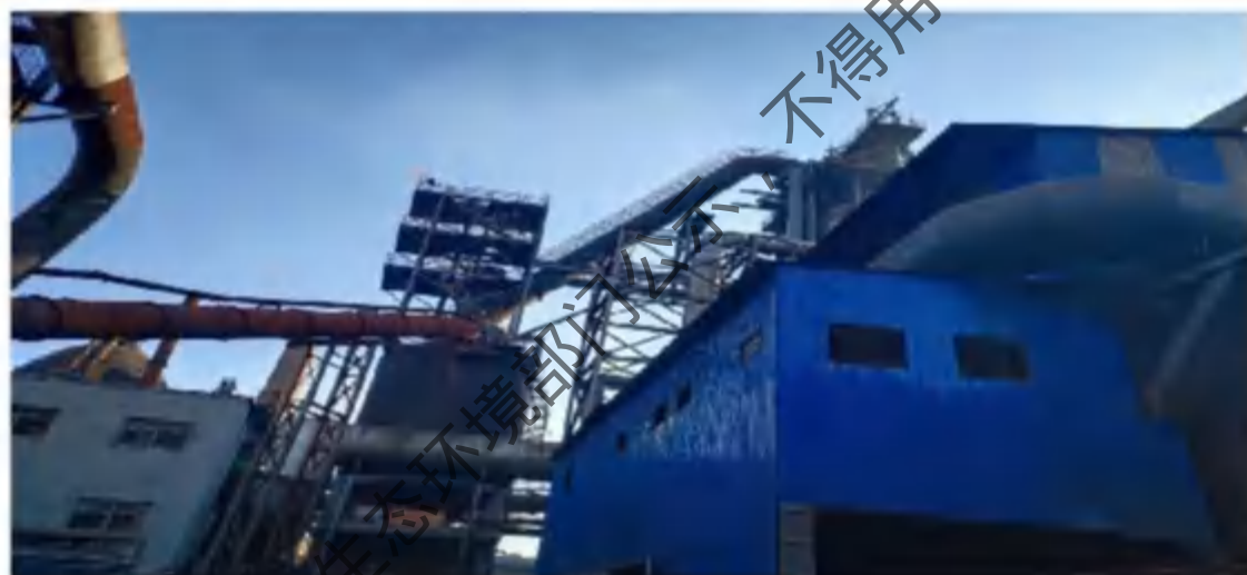
④高炉上料皮带运输处无抑尘措施。
